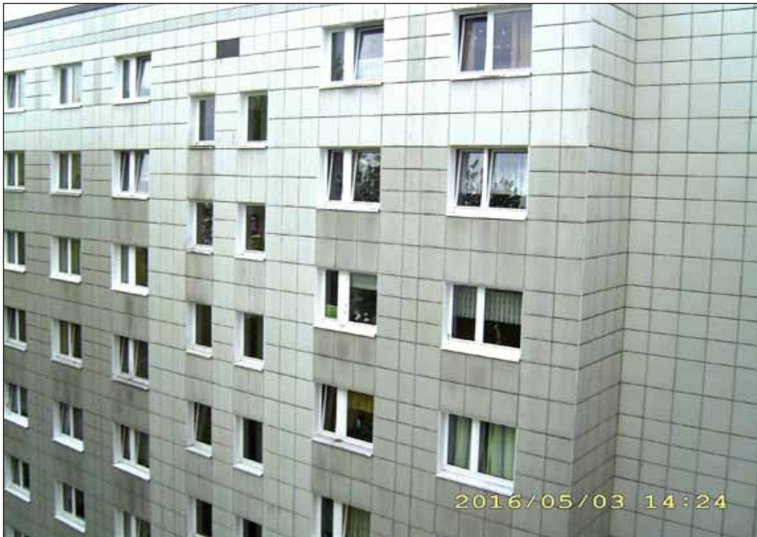
Abb. 4: „Plattenbaufassade“ Karl-Marx-Allee 69, Nordostseite. Fenster ohne äußeren Sonnenschutz, nach Wärmedämmung der Außenwände 1996, keramische Beschichtung. Quelle: Aktionsbündnis
